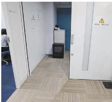
ドアを引き戸の自動ドアにバリアフリー化
